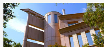
Building 3 - Av. Esplugues
